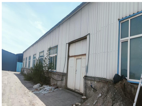
贮存中心东侧空仓库
