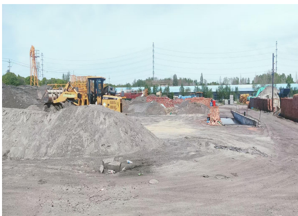
贮存中心北侧料场
