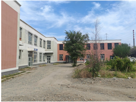
项目区东侧（食堂）
