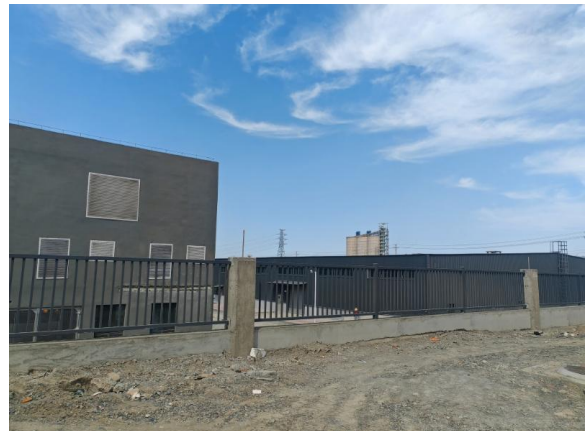
项目区北侧（厂房）
